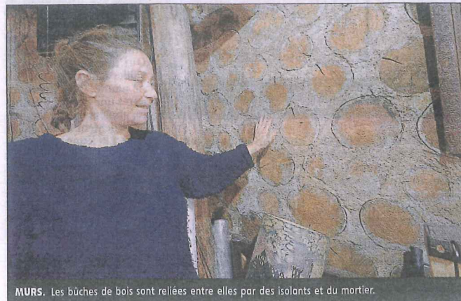
MURS. Les bûches de bois sont reliées entre elles par des isolants et du mortier.
