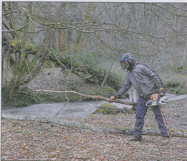
PASSAGE. Les arbres malades ou jugés néfastes pour l'évolution de la forêt sont coupés, puis dégagés du chemin afin de sécuriser les lieux fréquentés par les promeneurs. PHOTOS STEPHANE LEFEVRE
